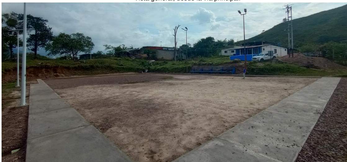
Vista general interna.
