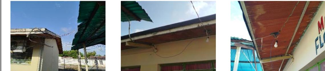
Sistema eléctrico funcionando de manera deficiente (con poca iluminación) y con problemas de seguridad, presentan conexiones superficiales
