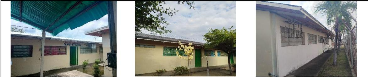
Losas de techo impermeabilizadas, ausencia de canales y bajantes de aguas de lluvia
